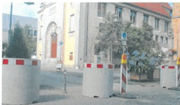
Diese Betonpoller in der Langen Straße sollen Szenen wie vor zwei Jahren in Nizza verhindern helfen.
